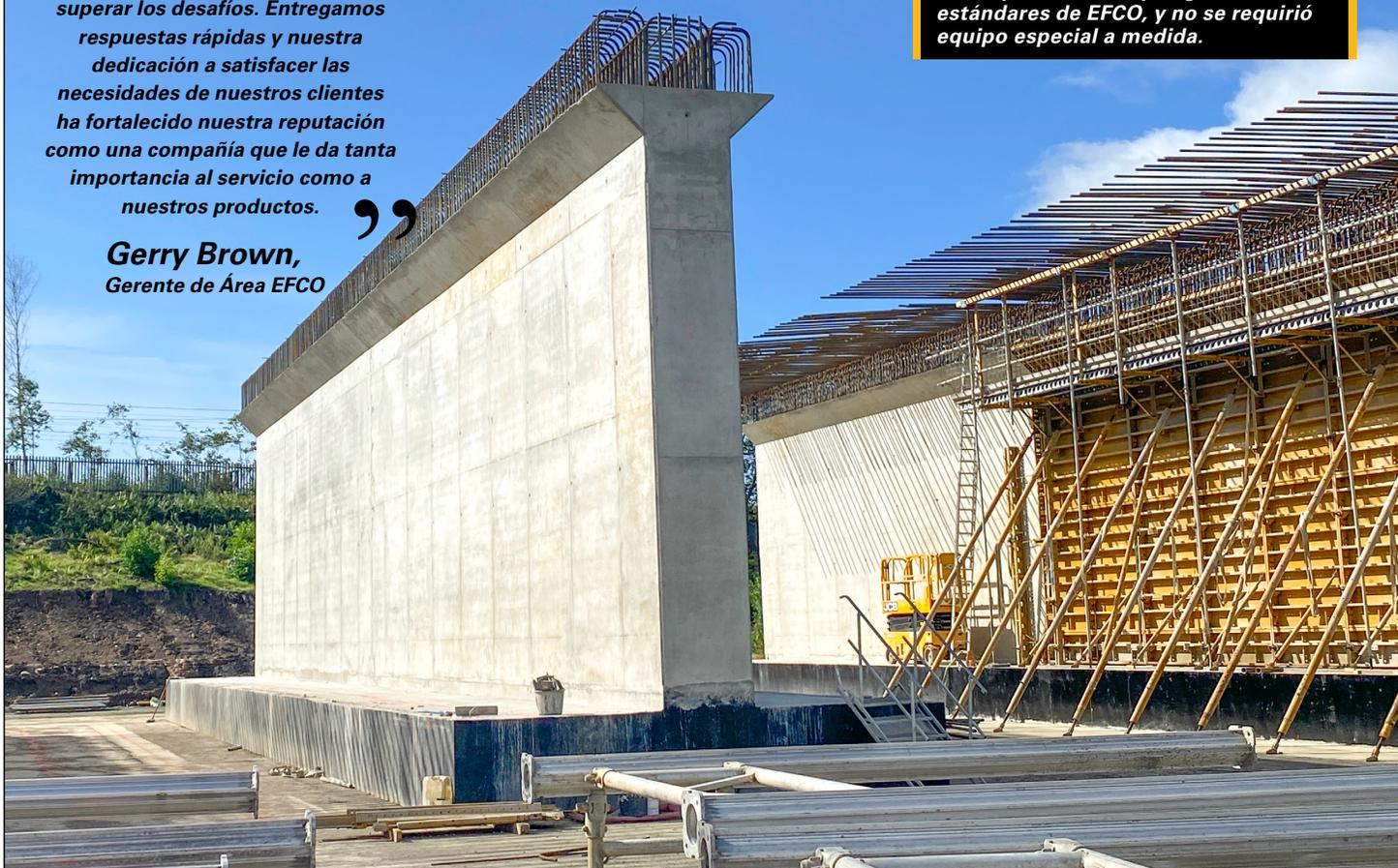
grandes ensambles de *PLATE GIRDER*, de 16 m x 8 m, que pesaban hasta 14,7 toneladas. Estos grandes ensambles de *PLATE GIRDER* se ciclaron sin alineadores, lo que redujo la mano de obra en el ensamble inicial y mantuvo los costos bajos para un ciclado eficiente. El espaciado entre tensores y la terminación a la vista que se obtiene con los paneles *PLATE GIRDER* redujeron la necesidad de reparaciones en las uniones y mantuvieron los costos de mano de obra bajos.
