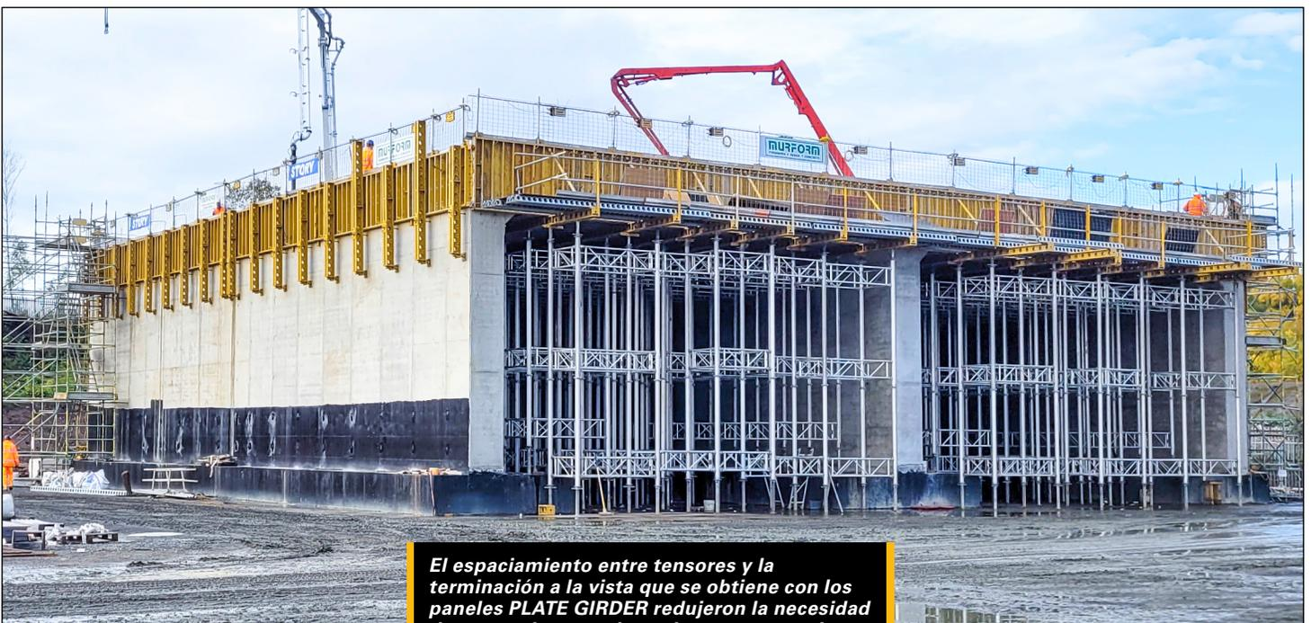
El espaciamiento entre tensores y la terminación a la vista que se obtiene con los paneles PLATE GIRDER redujeron la necesidad de reparaciones en las uniones y mantuvieron los costos de mano de obra bajos.
