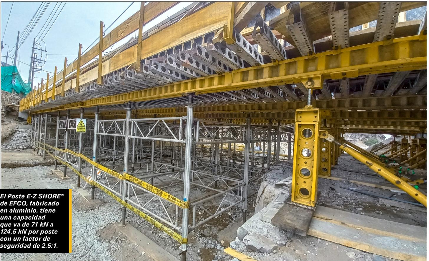
El Poste E-Z SHORE® de EFCO, fabricado en aluminio, tiene una capacidad que va de 71 kN a 124,5 kN por poste con un factor de seguridad de 2.5:1.
