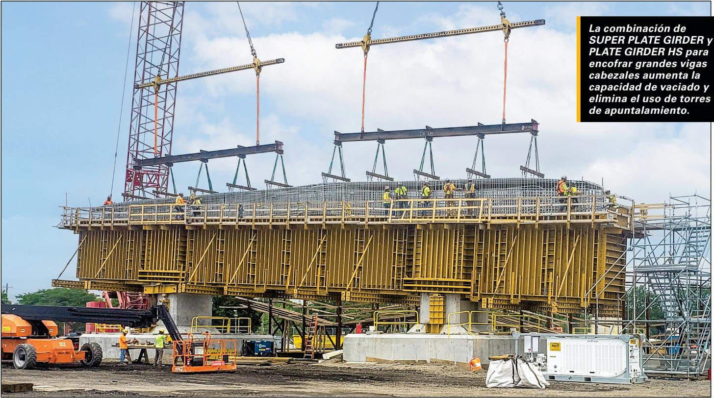
La combinación de **SUPER PLATE GIRDER** y **PLATE GIRDER HS** para encofrar grandes vigas cabezales aumenta la capacidad de vaciado y elimina el uso de torres de apuntalamiento.
