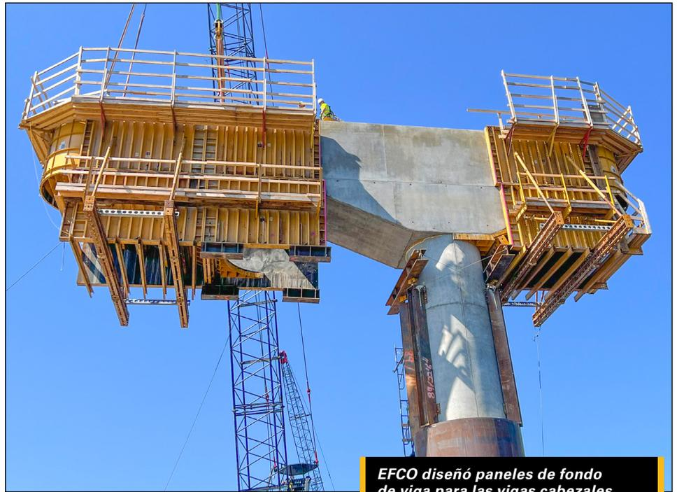
EFCO diseñó paneles de fondo de viga para las vigas cabezales montados alrededor de la columna, eliminando la necesidad de rellenos de madera.
