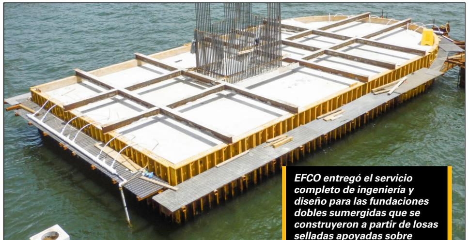
EFCO entregó el servicio completo de ingeniería y diseño para las fundaciones dobles sumergidas que se construyeron a partir de losas selladas apoyadas sobre pilares prefabricados.
