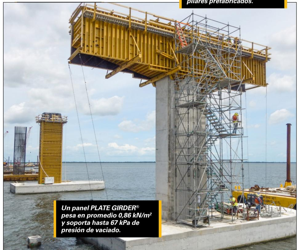
Un panel **PLATE GIRDER**® pesa en promedio 0,86 kN/m<sup>2</sup> y soporta hasta 67 kPa de presión de vaciado.
