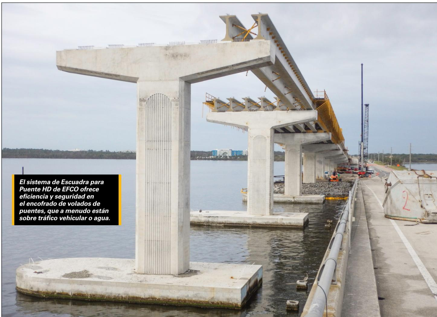
*El sistema de Escuadra para Puente HD de EFCO ofrece eficiencia y seguridad en el encofrado de volados de puentes, que a menudo están sobre tráfico vehicular o agua.*
