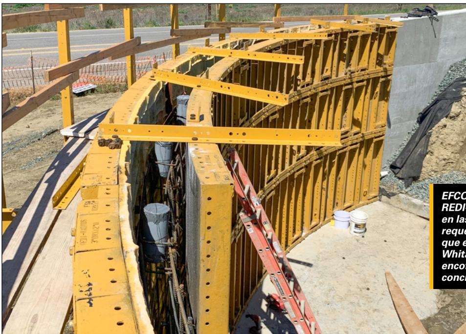
*EFCO entregó los paneles REDI-RADIUS ya curvados en las dimensiones requeridas, permitiendo que el personal de Whitaker montara el encofrado y vaciara el concreto rápidamente.*
