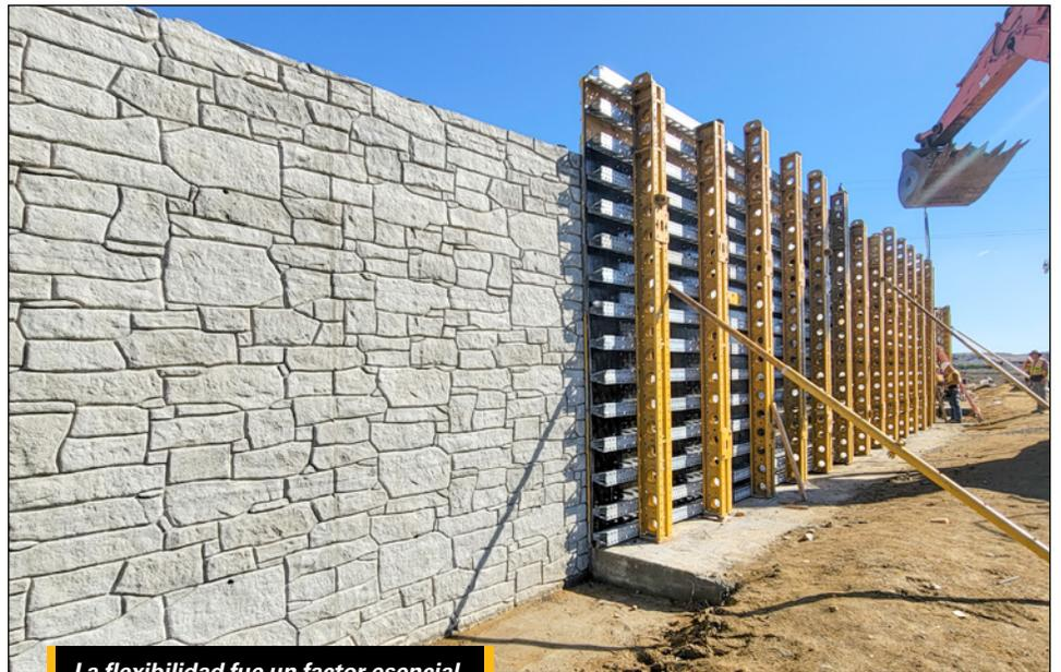
*La flexibilidad fue un factor esencial en la solución de encofrado para Whitaker Construction Group debido a la cantidad de escalones en la fundación.*
