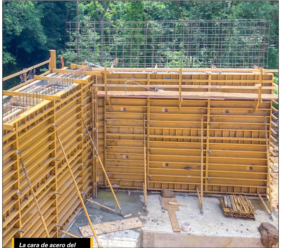
La cara de acero del panel PLATE GIRDER® cumple doble función ya que además de ser la cara de contacto del panel, actúa como el alma rigidizadora.
